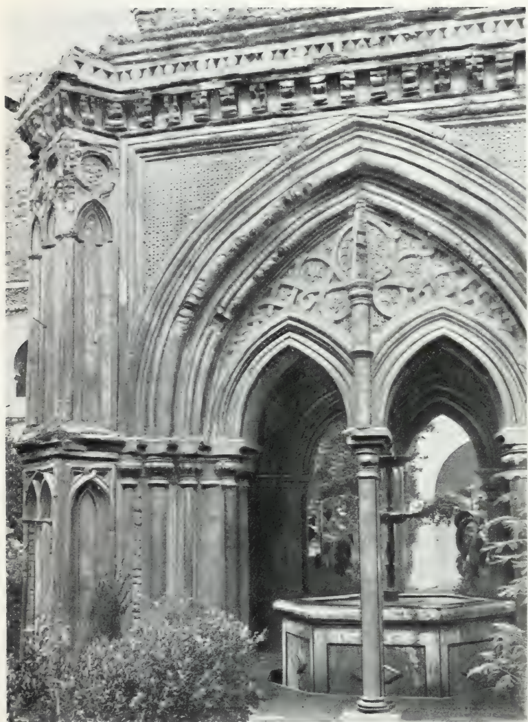
DETALLE DE LA GLORIETA CENTRAL
